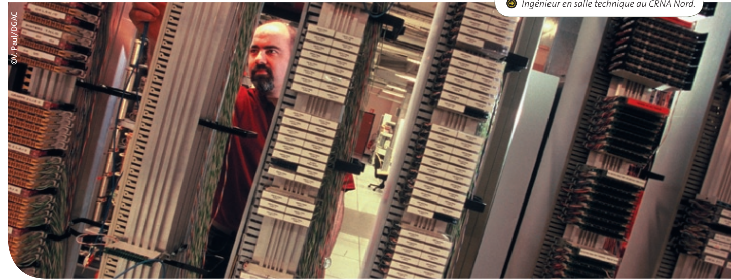
Ingénieur en salle technique au CRNA Nord.
